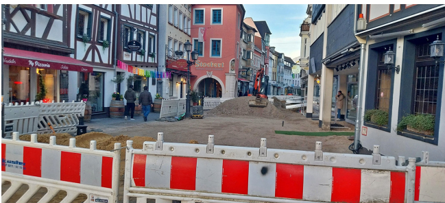
Abb. 3: In Ahrweiler gibt es noch zahlreiche Baustellen zur Beseitigung der Hochwasserschäden.
