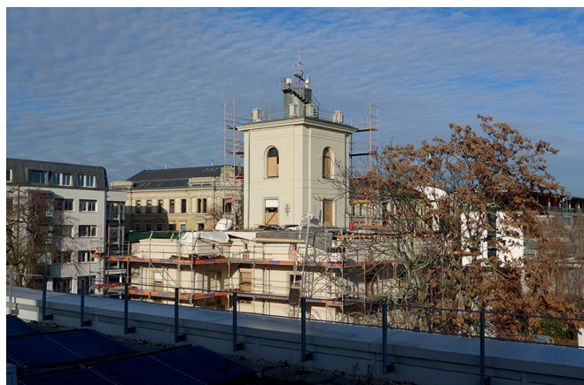
Abb. 3: Blick auf das alte LIM-Gebäude, welches gerade saniert wird (© Birgit Berger).
