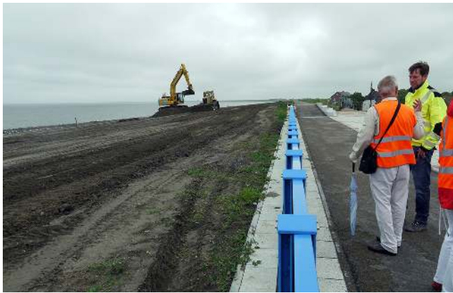
Abb 3.: Deichbaustelle mit Glaswand (© Helmut Skade).
