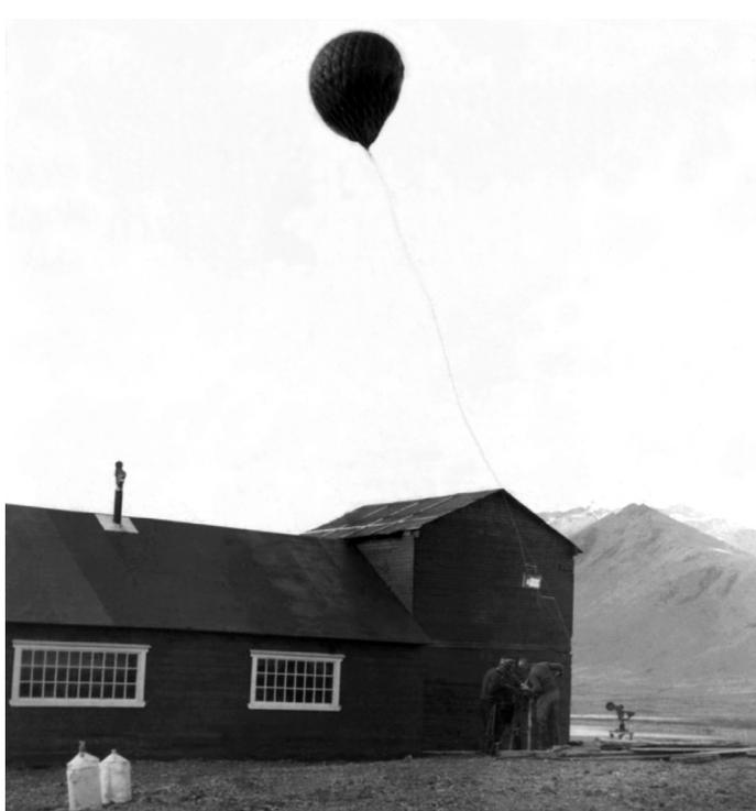
Abb. 3: Fesselballonsondierung zur Erfassung von Temperatur und Luftfeuchte der unteren Troposphäre auf Spitzbergen 1912/13.
