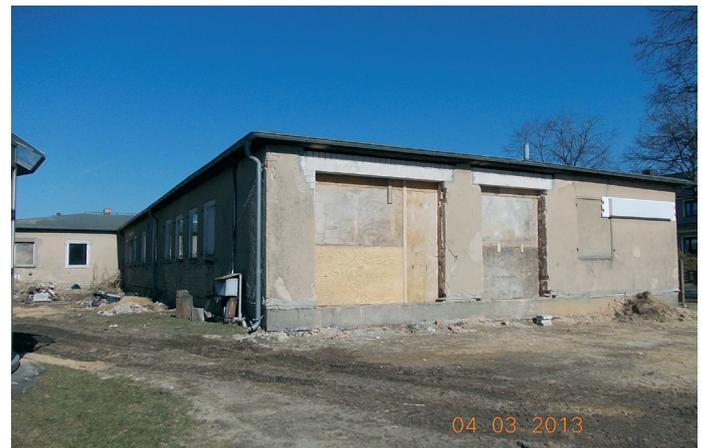
Abb. 2: Sanierungsprojekt Radiosondenprüfzentrale nach 4 Bauwochen; die Durchbrüche zum Anbau mit zukünftigem Haupteingang sind bereits geschaffen; das Fundament für den Anbau wird Ende März gegossen (Foto: Stiller 4.3.13).
