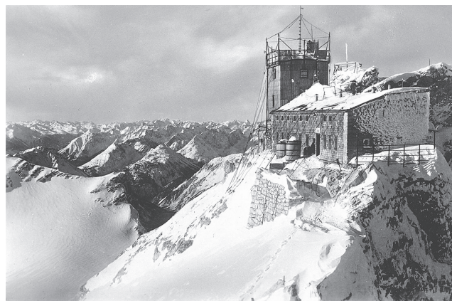
Abb. 2: Die Wetterstation Zugspitze (Turm) mit dem direkt angrenzenden Münchner Haus vor 1938 (Herbst 1938: Sprengung des Westgipfels; hier im Hintergrund rechts). © Archiv des DWD, Quelle: Bildkunst-Verlag Gg. Poppe, Bad Kissingen / Aufnahme: H. Huber.
