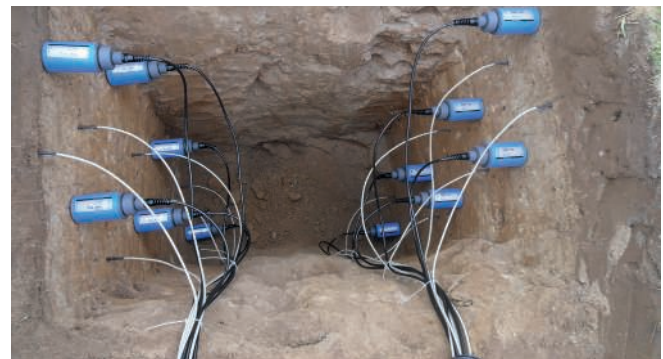
Abb. 1: Installation eines Bodenmessfeldes (2 Profile): Grube bis 1,5 m Tiefe (© DWD).
