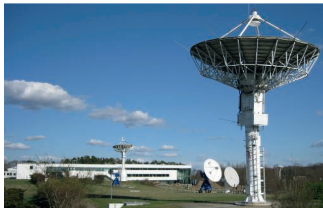
Abb.1: Schwenkantennen für den Satellitenempfang auf dem Gelände des DLR in Neustrelitz; im Hintergrund der 2012 fertig gestellte neue Gebäudekomplex (© DLR-Neustrelitz).
