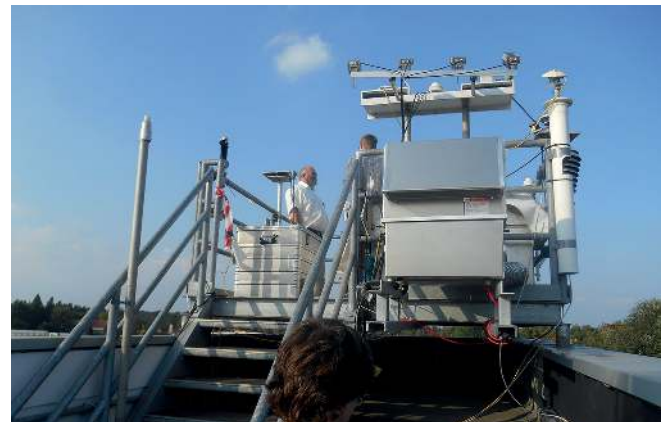
Abb. 6: Dachaufbauten des IMuK zur Strahlungsmessung (© Christian Koch).
