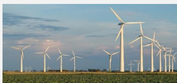
Onshore Windparks in Deutschland, UK, Frankreich
