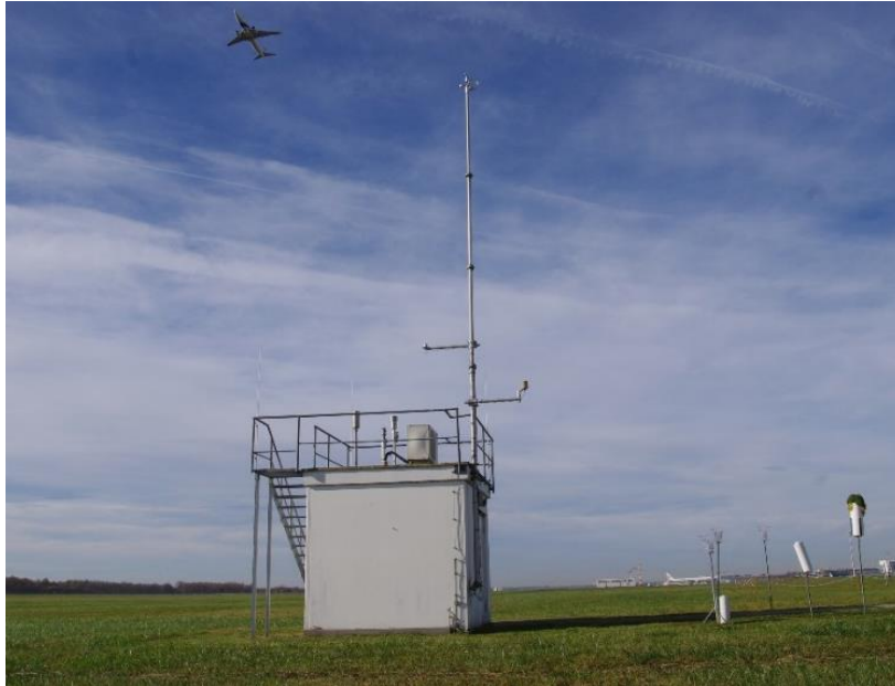
Stationäre Luftgütemessstation LHY7
