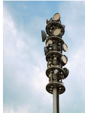
Abb. 1: Regenmessen mit dem Mobilfunknetz: Je mehr Niederschlag fällt, desto schwächer wird das Signal, mit dem die Funkmasten Informationen austauschen (© Cynthia Ruf, KIT).
