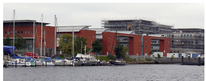
Abb. 1: GEOMAR-Komplex am Kieler Ostufer (© Helmut Skade).
