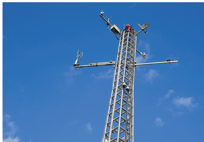
Abb. 2: Meteorologischer Messmast auf dem Gebäude des MPI-BGC.
