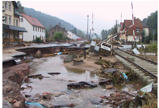
Abb. 2 oben: während der Sturzflut, unten: nach an der Müglitz in Schlottwitz, einem Ortsteil von Glashütte (Quelle: Harald Weber/Wikipedia).
