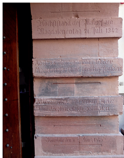
Abb.: Flutmarken der Mainhochwasser am Torbogen des südlichen Eingangs zum Roten Bau des Rathauses in Würzburg (© Martin Bauch).
