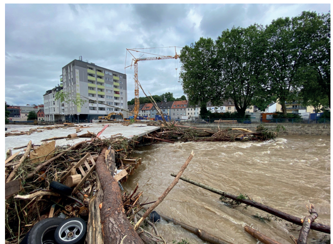
Abb. 6: Zu dem Zeitpunkt noch im Bau befindliche neue „Marktbrücke“ in der Hagerer Innenstadt am Mittag des 15.07.21. Die Brücke wurde komplett überspült und es hat sich eine Menge an Treibgut aufgestaut. Dennoch gab es nur leichte Schäden (© Bastian Rissling).
